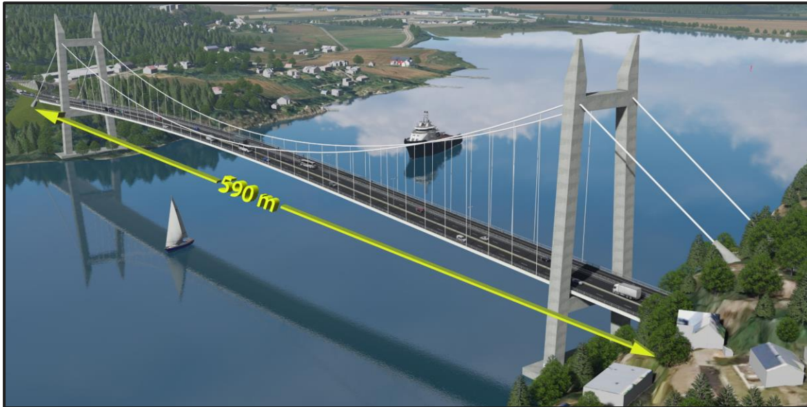
Figur 1-2: Høybru over Vestfjorden som hengebru med H-tårn.
