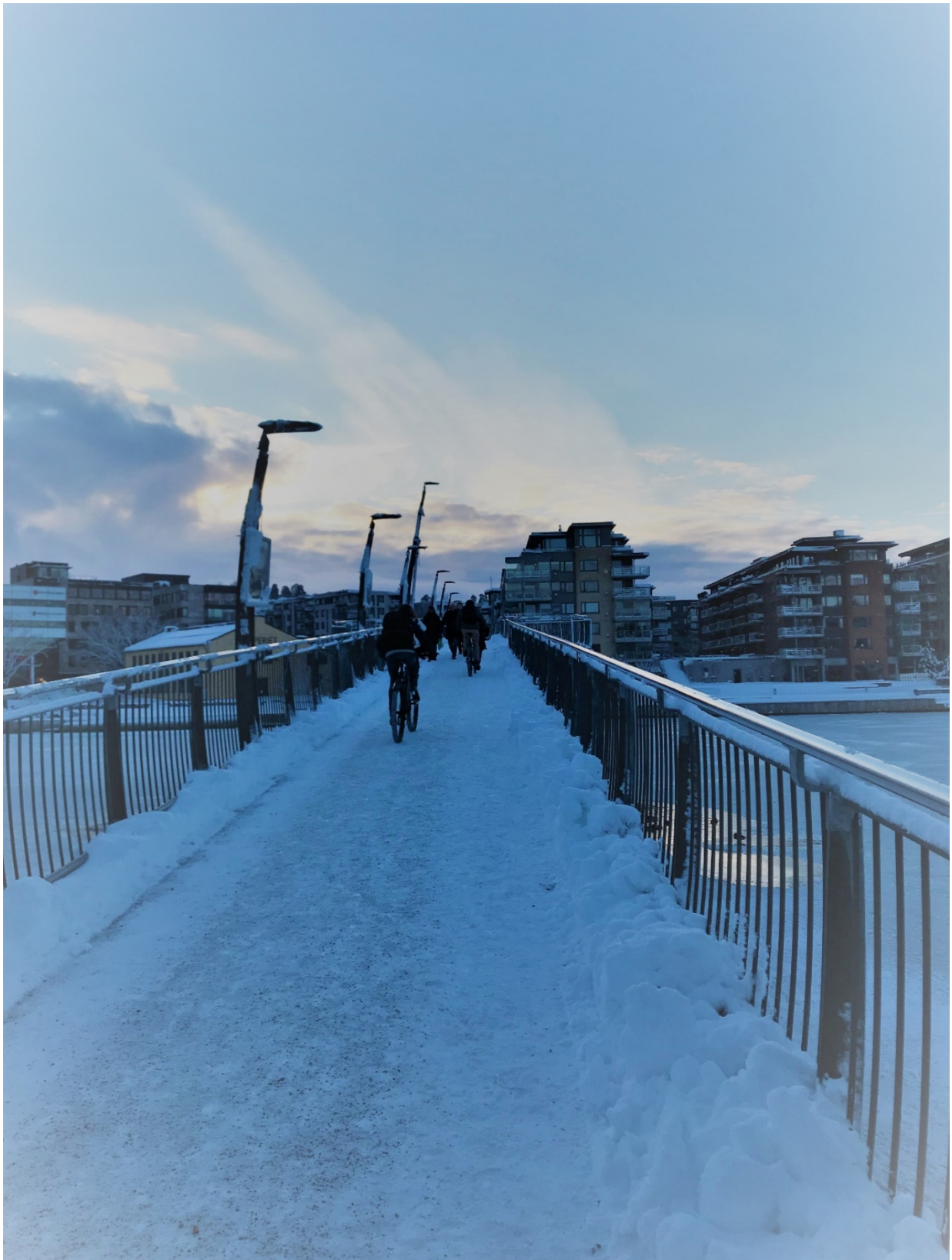
Figur 22: Vinterdrift på Kaldnesbrua i Tønsberg sentrum. Bildet er tatt vinteren 2018 og illustrerer utfordringer knyttet til vinterdrift av anlegg for gående og syklende. Foto: Norconsult AS.
