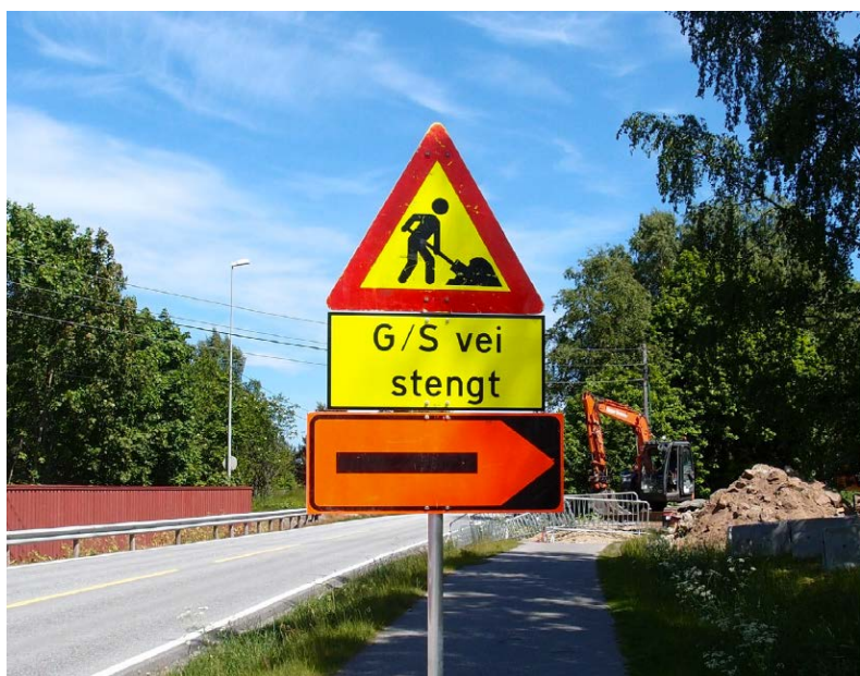
Figur 20: Arbeid på veg veg medfører ofte økt risiko for gående og syklende. Foto: Statens vegvesen, forside SVV-rapport nr 680.
