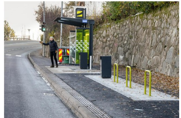
Eksempel på kantstopp med leskur. Foto: Svv
