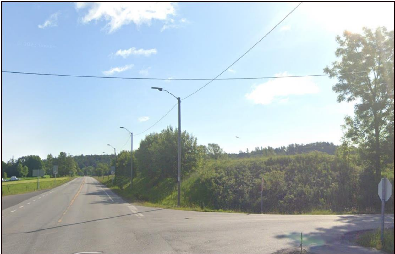
Figur 20: Foto fra strekningen, kryss fv. 310 x fv. 3182 dyrket mark med løsmasseskjæring, vest i planområdet. Kilde: Googlemaps.
