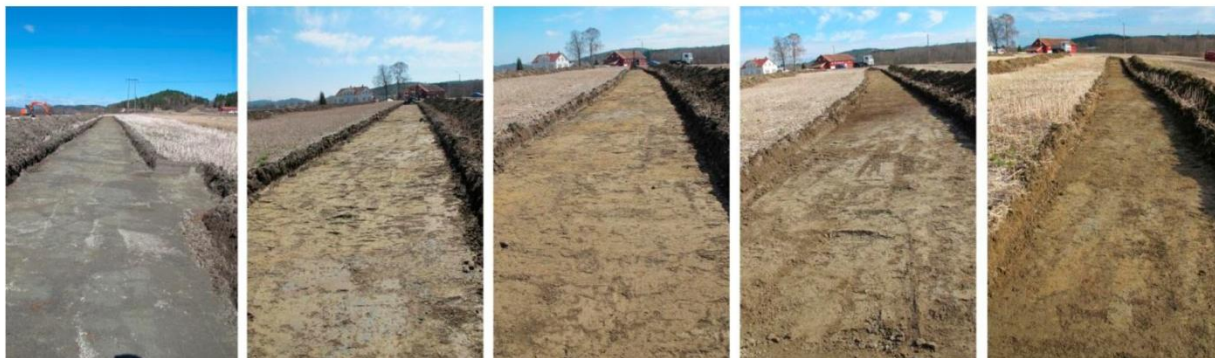
Figur 5. Fra venstre: Sjakt 13801 (mot nordvest), 13904, 13805, 13808 og 13809 (mot sørøst).
