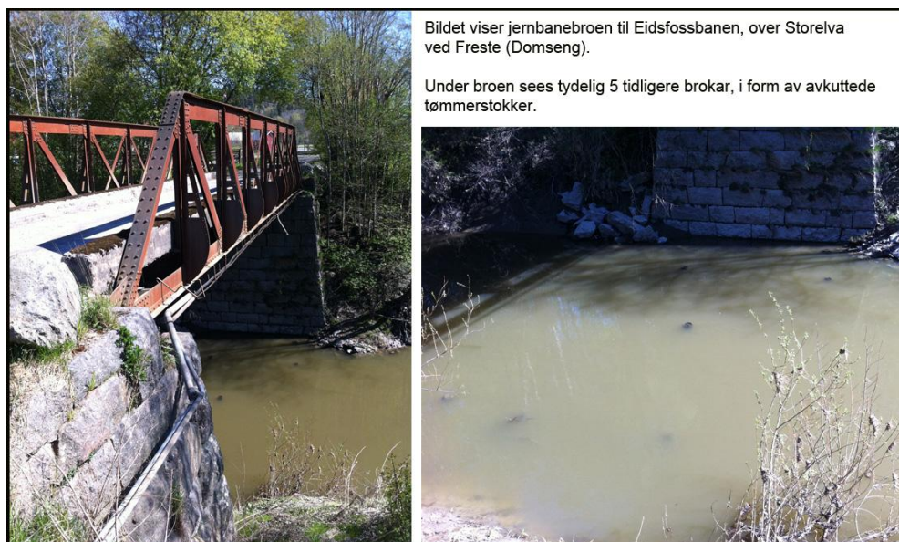
Figur 19, viser at det har vært en eldre bro under broen til Eidsfossbanen, pga. brokarene.
