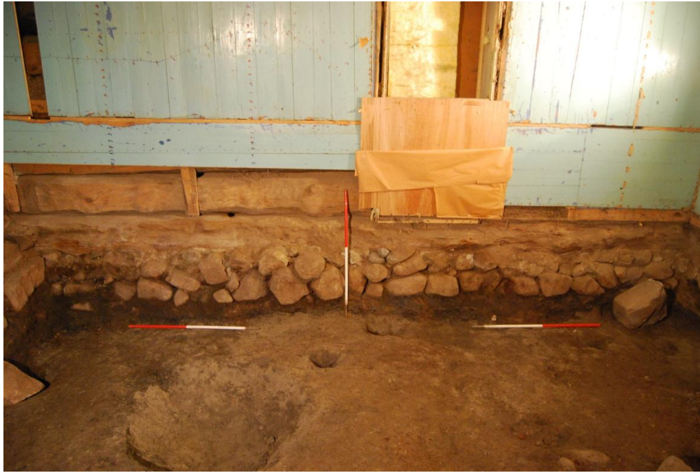
L8, syllstenar, de understa raderna av timmer. Sett mot nordväst.
