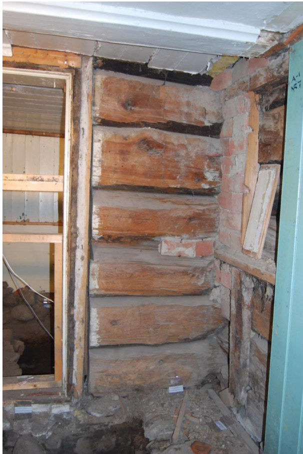
Skorstenens originalplacering. Sett mot nordöst. Fotograf: Jakob Johansson
