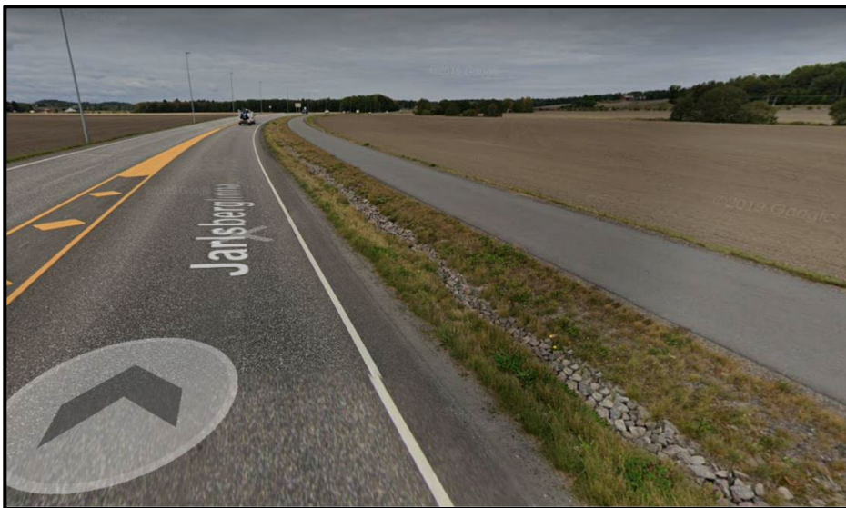
Figur 24 – Lukket overvannsløsning med infiltrasjon i grøfta.
